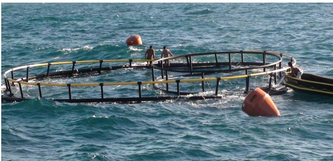
Figura 9: Fixação dos tanques-rede ao sistema fundeio.
